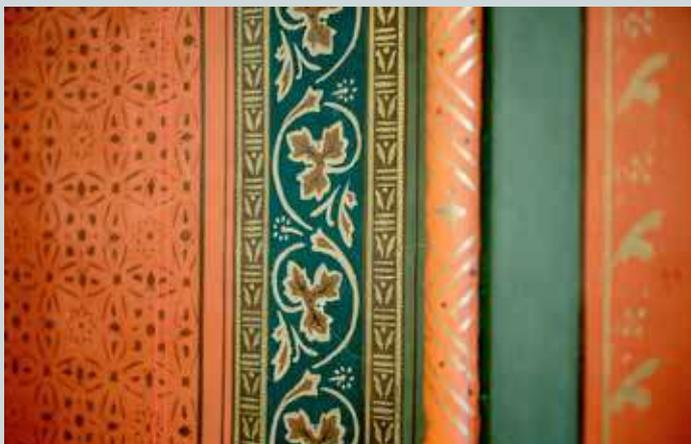
Bei der Rekonstruktion der Wandmalereien wurde zunächst eine Musterachse mit den ursprünglichen Ornamenten freigelegt, um anschließend alle Wandflächen entsprechend zu restaurieren. Mit der Rekonstruktion der Holzdecke und der Ausmalung der Aula konnte nach Aussage von Dr. Peter Königfeld vom Niedersächsischen Landesamt für Denkmalpflege ein besonders wertvolles und repräsentatives Zeugnis der Kulturrepoche des Historismus zurückgewonnen werden.
